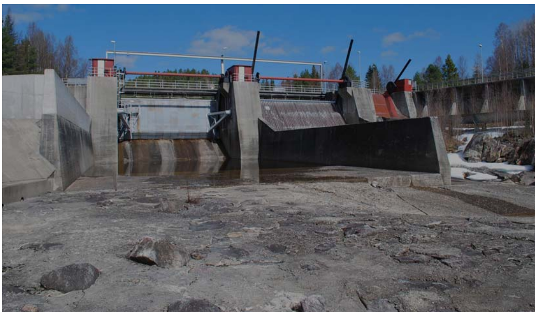
Figur 27. Edsele kraftverk sett nedifrån 2011.
