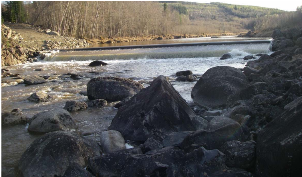
Figur 42. Fotografi nedifrån på det anlagda skibordet i Hjälta's torrsträcka. Fotografiet taget 2011-04-26.
