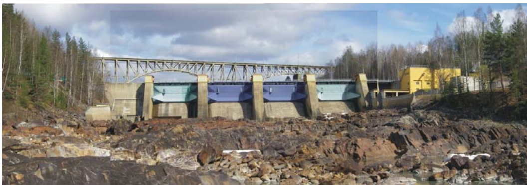
Figur 23. Forsmo kraftverk sett nedifrån 2011.
