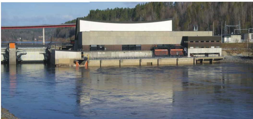
Figur 22. Sollefteå kraftverk sett nedifrån 2011.
