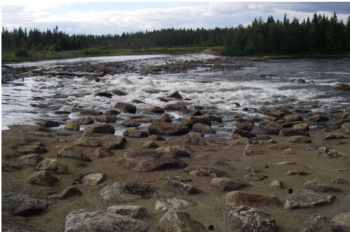
Figur 27. Den i betong anlagda tröskeln vid Gubbseleforsen. Vid låga flöden kommer fisk svårigen förbi här eftersom det inte anlagts något djupare parti.
