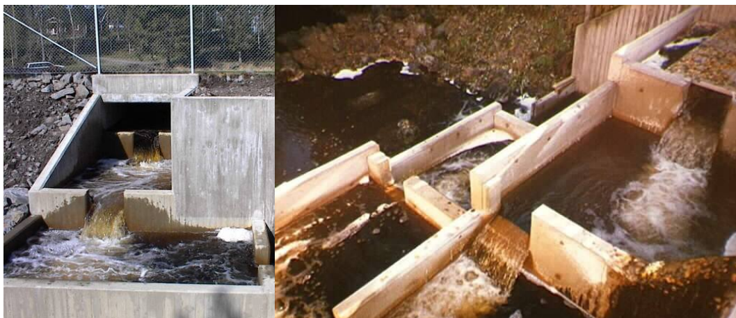
Figur 17. Exempel på två betongtrappor av bassängtyp. Den till vänster finns i Norrån och den till höger i Aspån, Västernorrland i bägge fallen.
