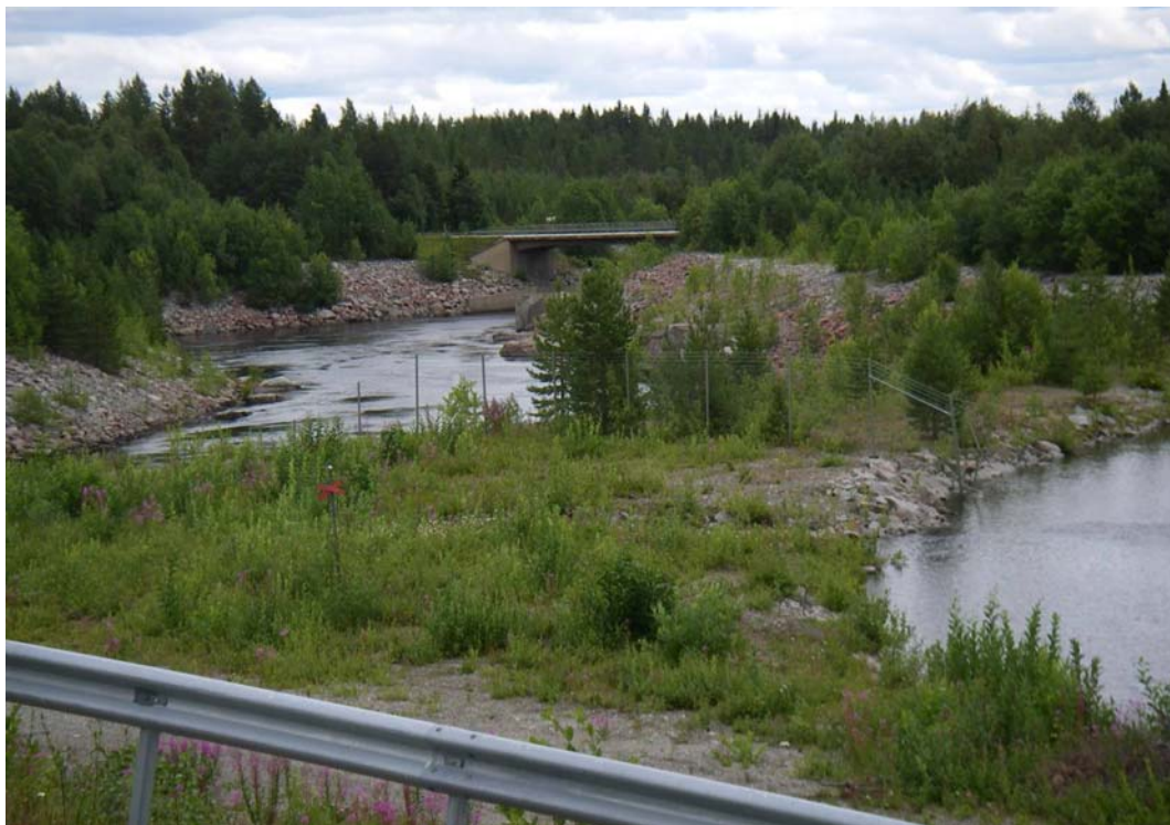
Figur 28. Området mellan Malgomaj och Volgsjön sett från Malgomajs regleringsdamm. Till höger i bilden syns den del spegeldammen som är kvar efter kraftverkets anläggande. Till vänster är kraftverkskanalen. Man kan se nivåskillnaden mellan spegeldamm och kraftverkets utloppskanal.
