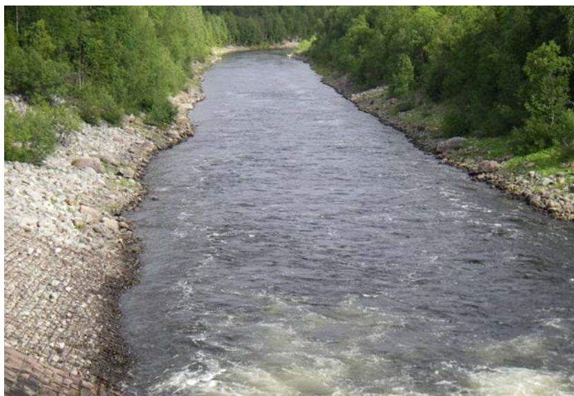
Figur 20. Den nedsänkta utloppskanalen ur Vojmsjödammen har en ganska jämn kant utan vegetation närmast vattnet. Eftersom mätpunkten för minimitappningen ligger nedströms kanalen kan hela kanalen, som är mer än 1,5 km, i princip vara torr.
