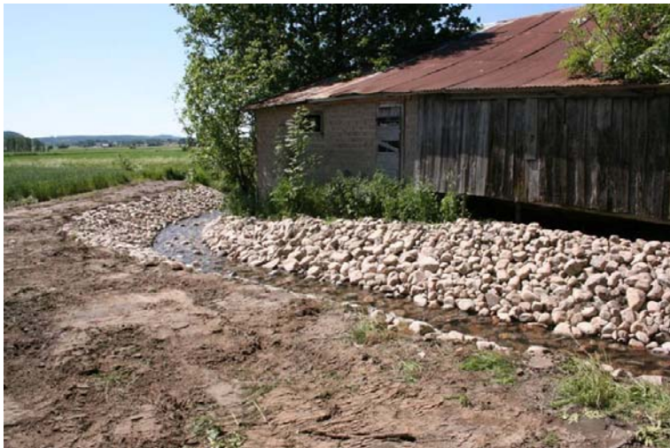
Figur 13. Ett omlöp i Horsabäcken, Halland. Denna naturliga "bäck" runt hindret är både vandringsled och barnkammare för fisk.
