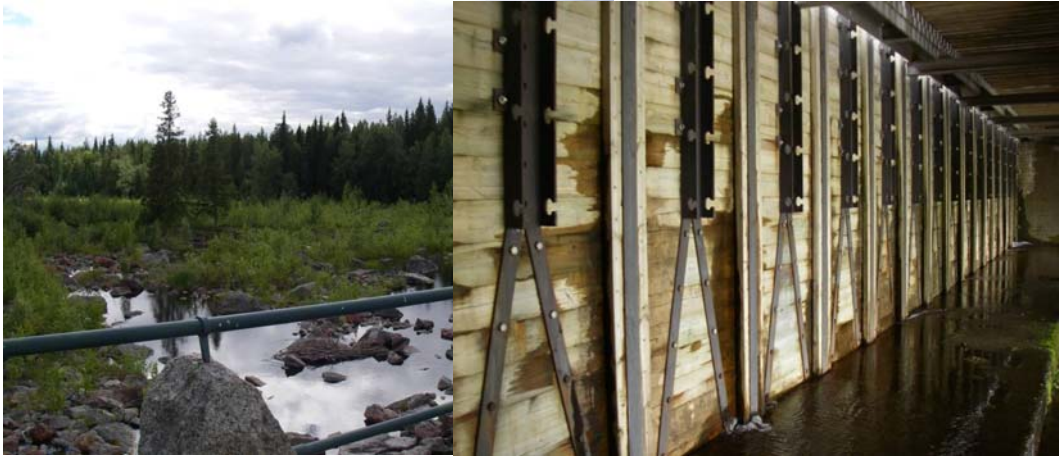
Figur 34 visar fotografier från sommaren 2008. Till vänster är vyn nedåt från dammen och det högra fotografiet visar spettluckorna underifrån.
