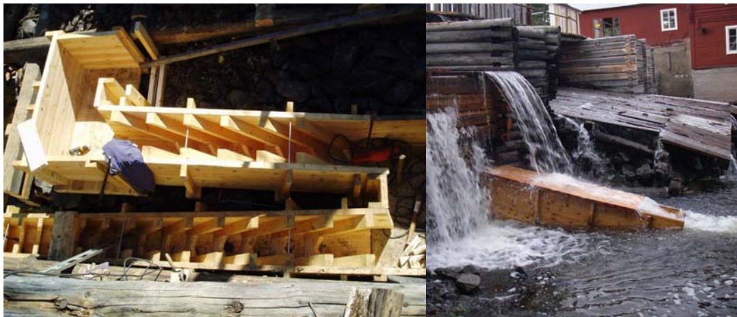
Figur 14. En denilrännan byggd i Åflo kvarn, Jämtland. Rännan är byggd i kärnfura för att anpassas till kulturmiljön i övrigt. (Under hösten 2008 vandrade >40 öringar genom rännan och fångades i en fälla direkt uppströms).
